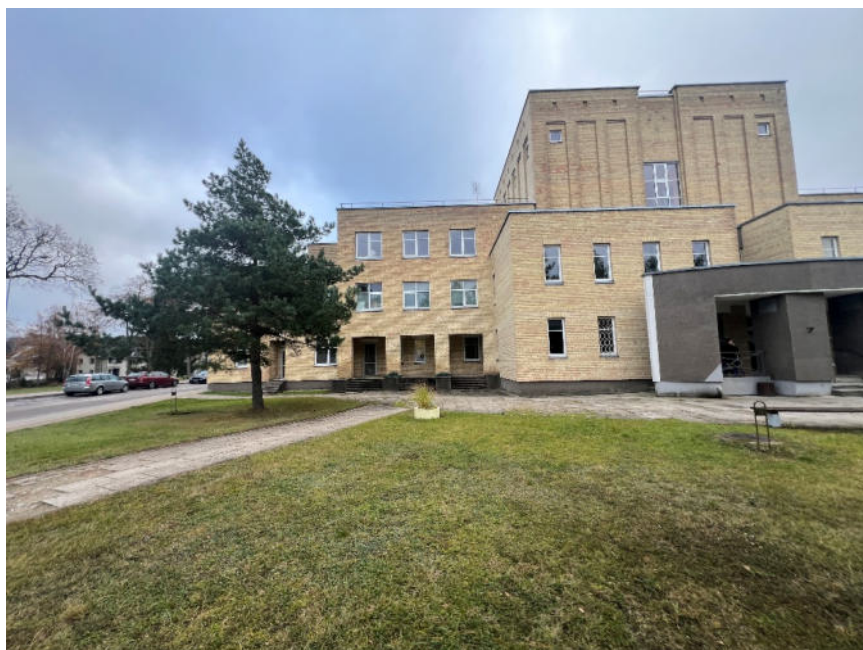
Fotofiksacija pv.1 būklės įvertinimui.
