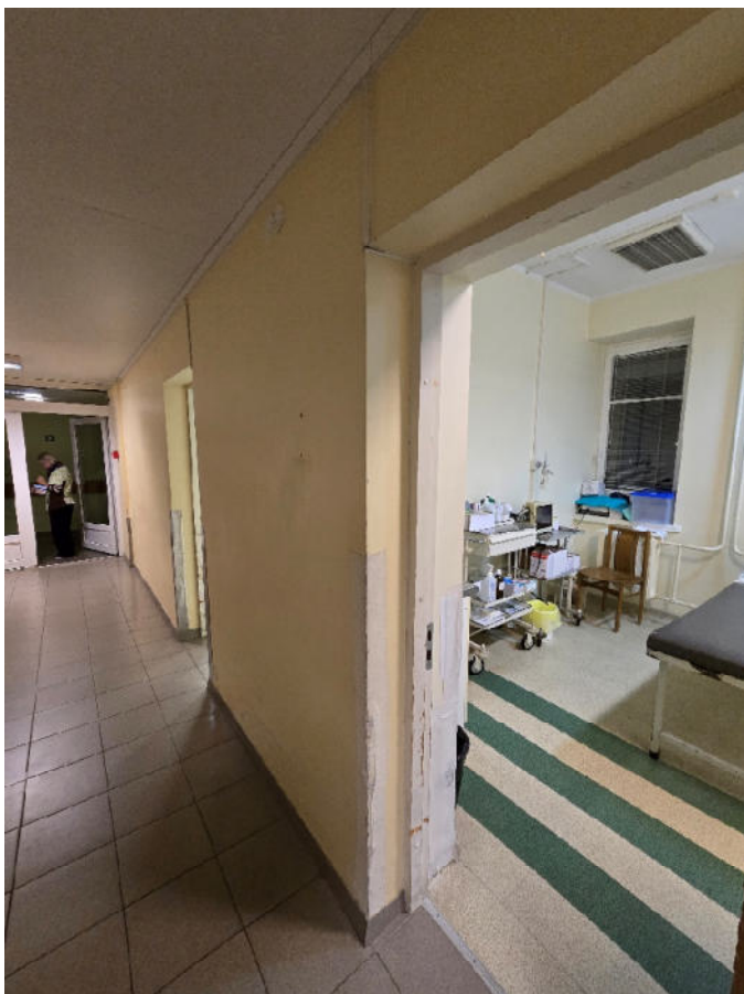
Fotofiksacija vidaus patalpų pv.4 būklės įvertinimui.
