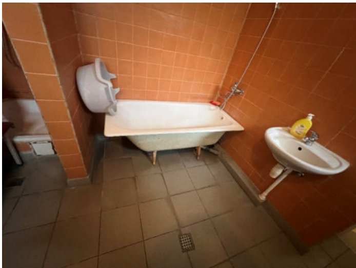
Fotofiksacija vidaus patalpų pv.3 būklės įvertinimui.
