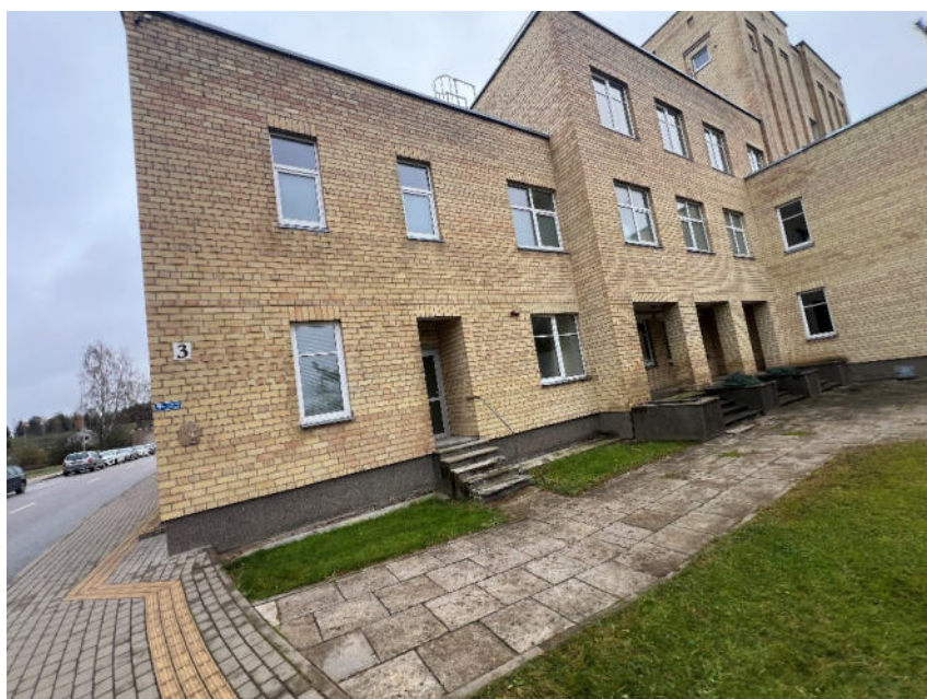
Fotofiksacija pv.2 būklės įvertinimui.
